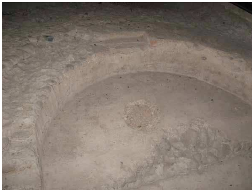
Fig. 7. Abside del presbiterio della cappella palatina (sulla parete dello stesso è presente l'intonaco originale)
